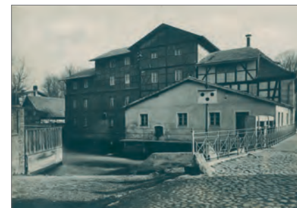
Die Burger Mühle, die um 1933 ihren 15 kV-Anschluss erhält
