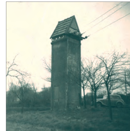
Eine typische Fertigteil-Trafostation in Gubrow
