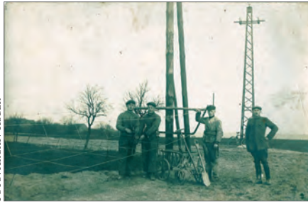
AEG-Monteur beim Schutznetzbau unter anderem auch über die Spreewaldbahn
