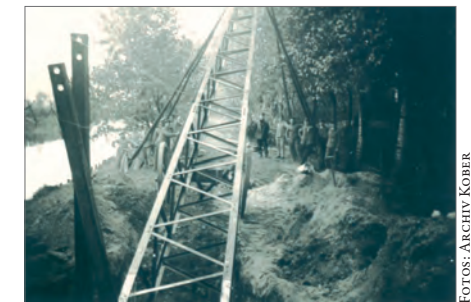
Ein Gittermast wird in Fließnähe gestellt.
