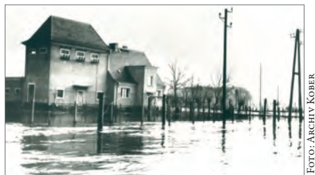
Die Schaltstation Burg und 15 kV-Leitungen im Frühjahrshochwasser 1940
