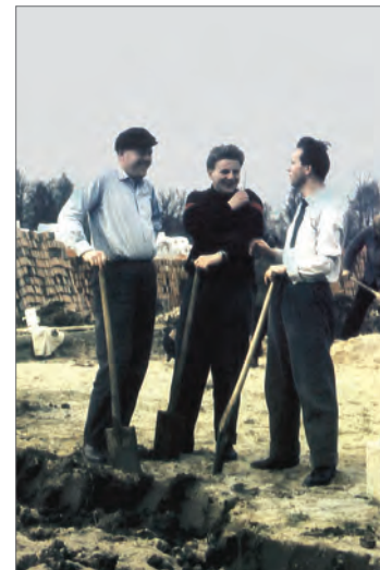
Die Lehrer Thonack, Bohg und Jannasch (v.l.n.r.) auf der Schulbaustelle
