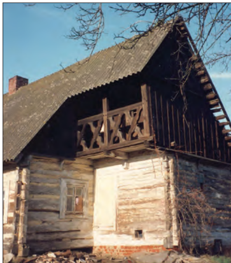
links: Die Wohnhausseite des Licher-Hauses mit dem Laubengang vor Beginn der Sanierungsarbeiten. Viel Geduld und Handarbeit stehen hier noch bevor.
