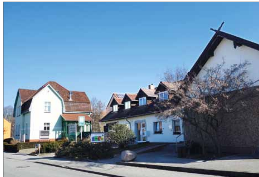
Das ehemalige Landambulatorium neben der „Villa Salisch“ (Hintergrund)
