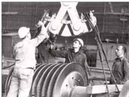
Turbinenmontage im Kraftwerk Vetschau
