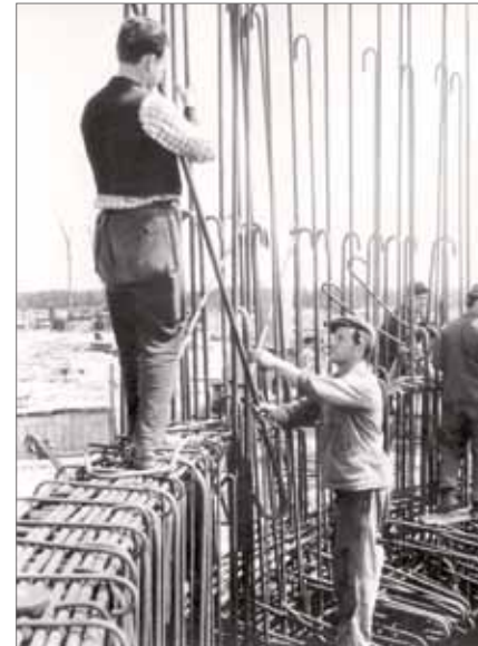
Eisenflechtarbeiten am Kraftwerksbau
