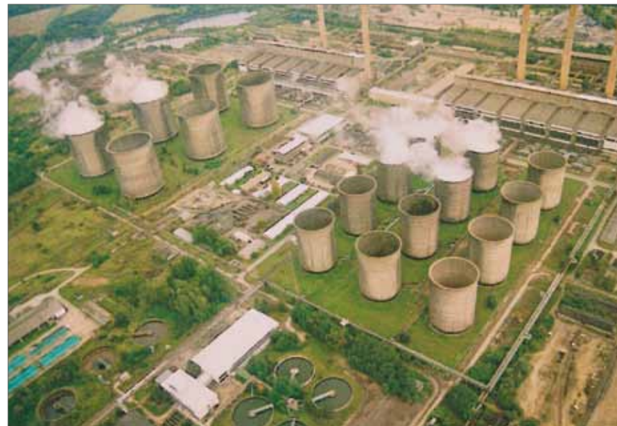
Kraftwerk Vetschau 1995, links unten die im Text erwähnte Warmwasserhalle für die Fischzucht
